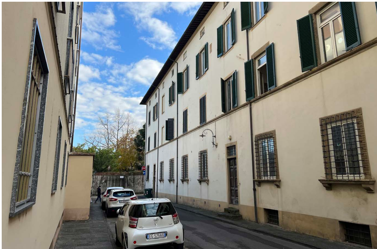
Punto di vista 07 - Facciata Nord - Via del Calcio
