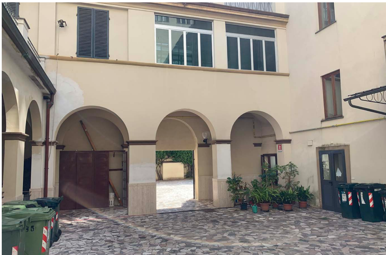
Punto di vista 21 - Cortile minore - facciata est - ambito collegamento con cortile Maggiore
