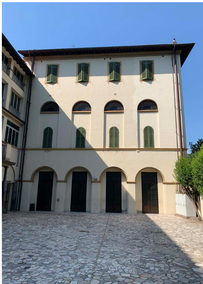
P.d.v. 19 - Cortile maggiore - Facciata sud
