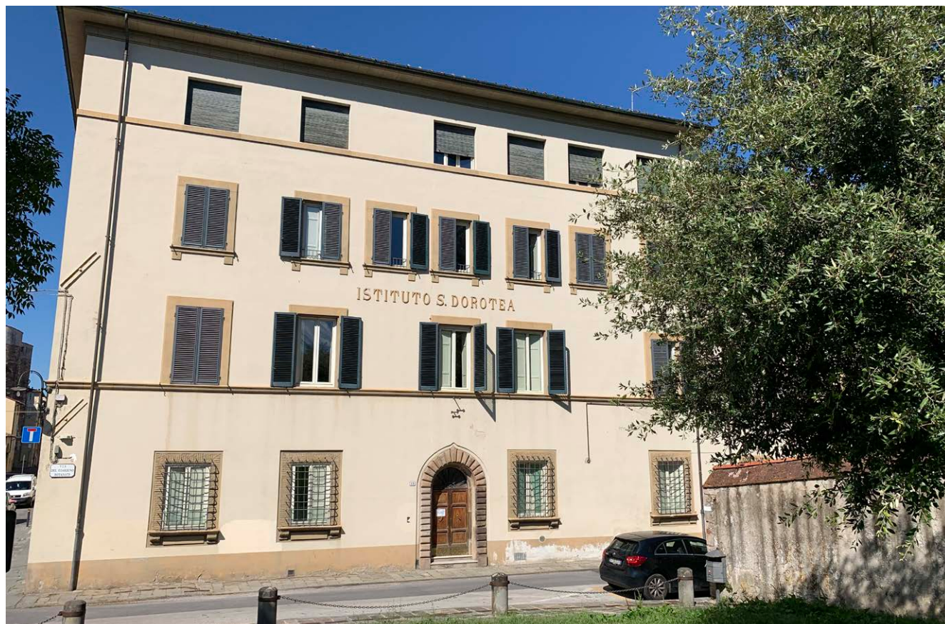
Punto di vista 01 - Facciata Sud - via del Giardino Botanico
