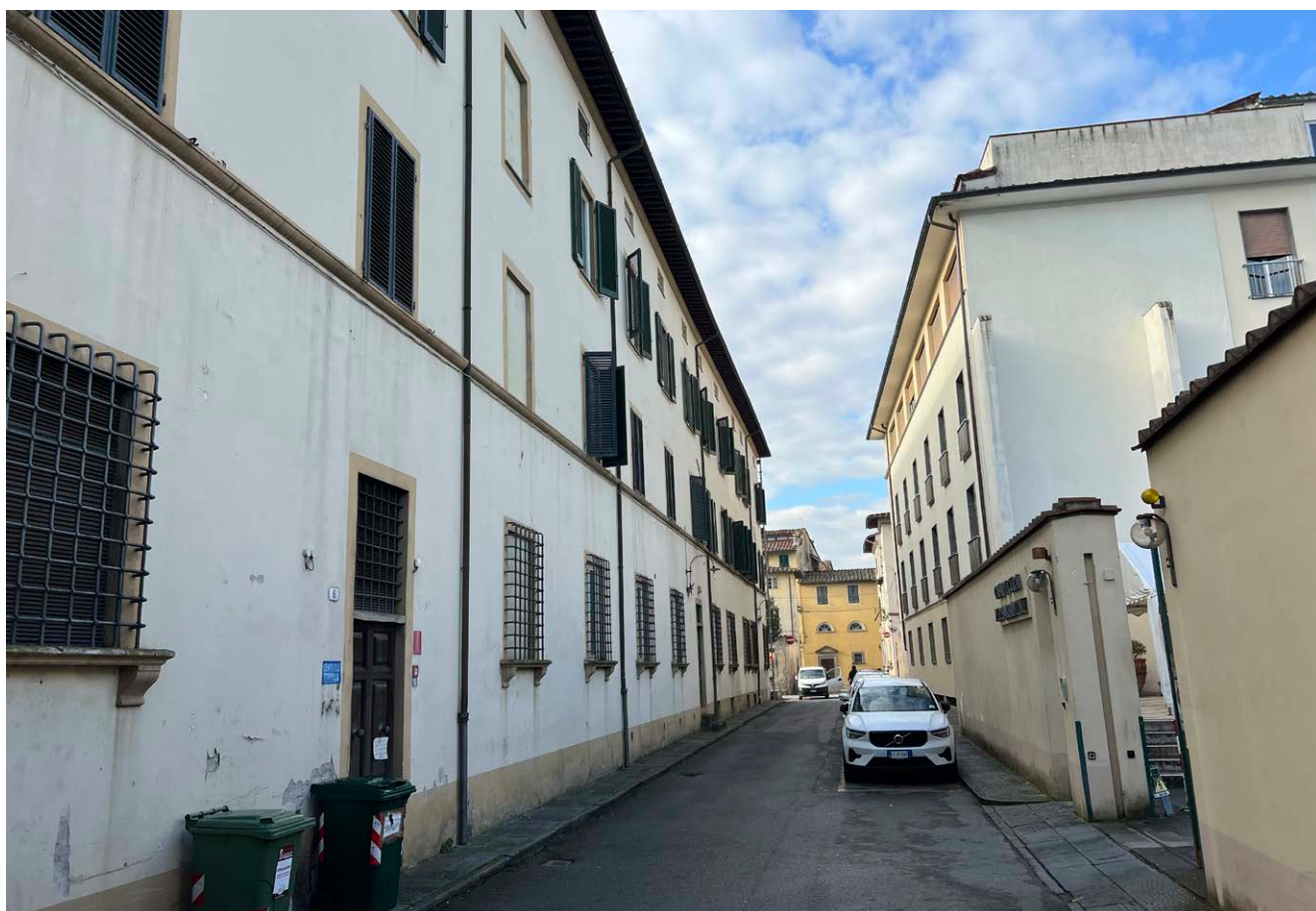
Punto di vista 08 - Facciata Nord - Via del Calcio
