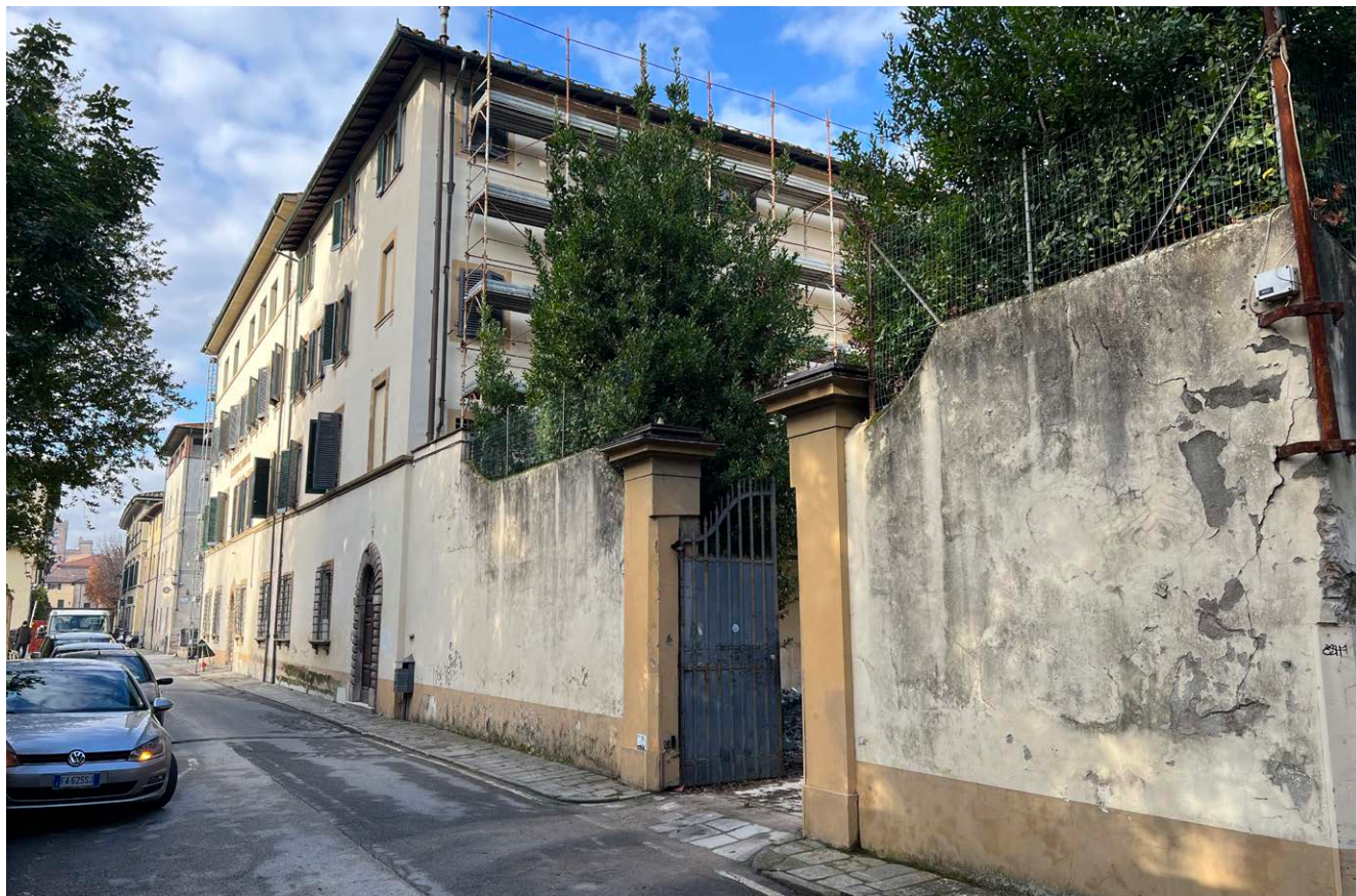
Punto di vista 04 - Facciata Sud - via del Giardino Botanico
