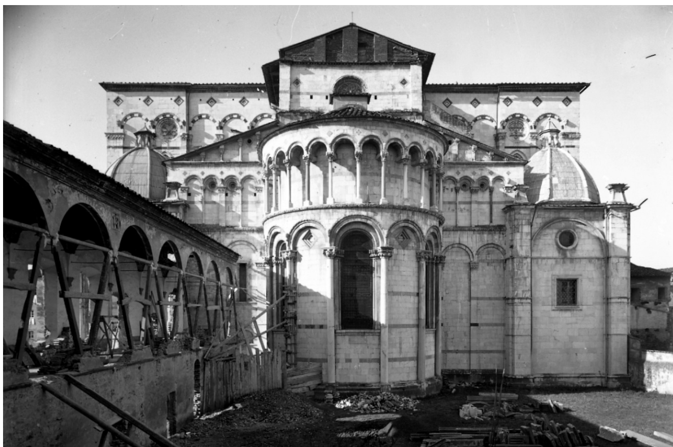
Duomo di San Martino: parte tergale con la galleria in fase di demolizione - Archivio Fotografico Lucchese – rif. ECF 1363 – Ettore Cortopassi (esec. ca. 1937-38)
