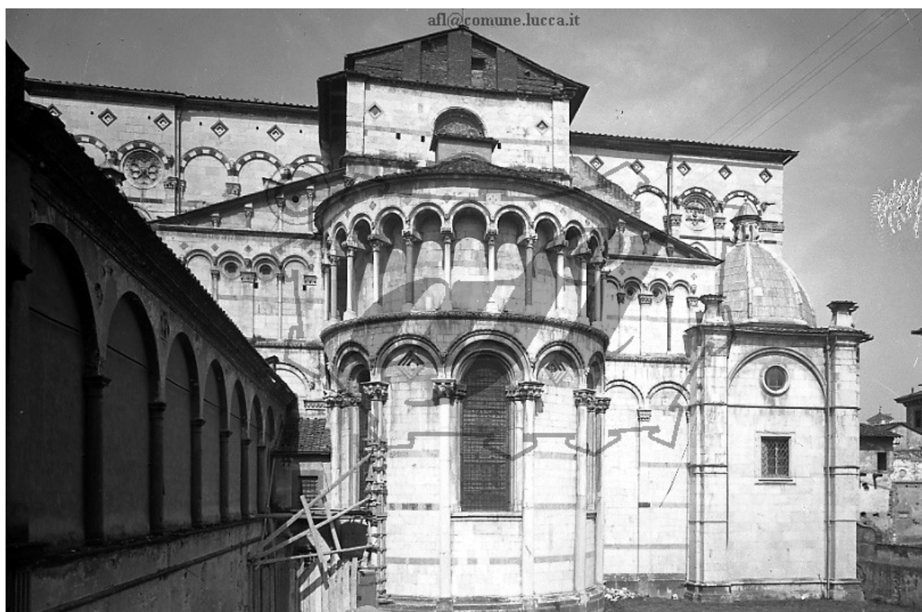
Piazzale Arrighi: lato est con la galleria tra il Duomo e l'Arcivecovato vista dall'Arcivecovato - Archivio Fotografico Lucchese – rif. ECN 2803 – Ettore Cortopassi (esec. 1930-37)
