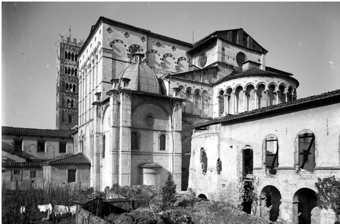
Duomo di San Martino: parte tergale con la galleria in fase di demolizione - Archivio Fotografico Lucchese – rif. ECF 1364 – Ettore Cortopassi (esec. ca. 1937-38)
